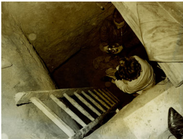
Blick in den Einstieg des verratenen Fluchttunnels
